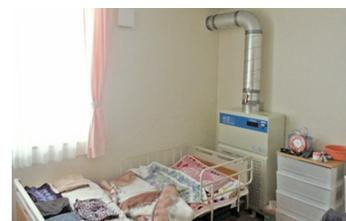
居室内に設置の簡易陰圧装置
