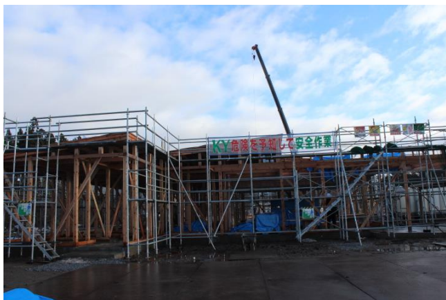
12月5日 【軸組建て方工事】
