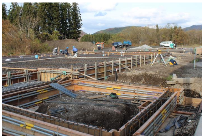
11月10日 【鉄筋・型枠工事】
