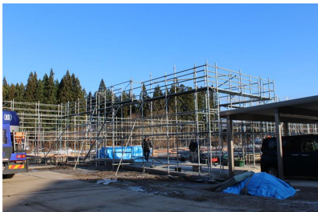
11月27日 【足場組工事】
